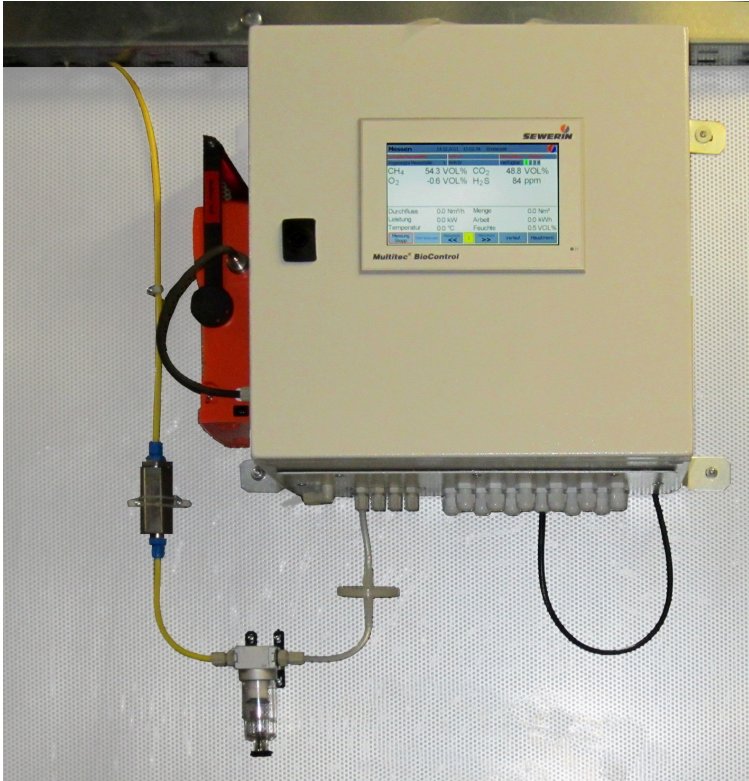
Fig. 4: Exemplo de uma instalação – BioControl 4 com um ponto de medição conectado
