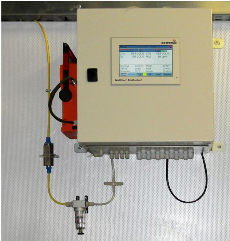
Fig. 4: Instalação da amostra – **BioControl 4** com um local de medição conexão conectada
